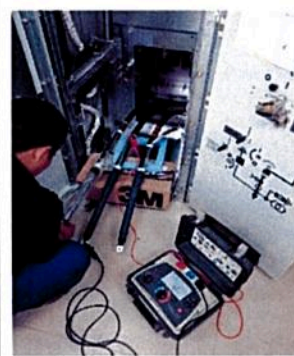
Prueba de aislamiento en puntas y cables.
