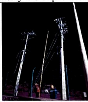
Energización alimentador #2 y #4.
