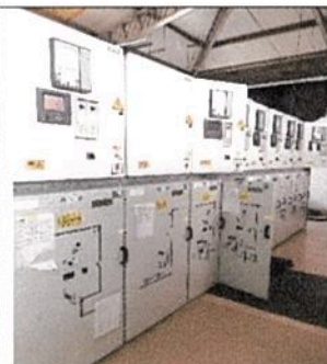
Celdas instaladas y energizadas.
