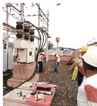
Conexión alimentador Caterpillar en k05.
