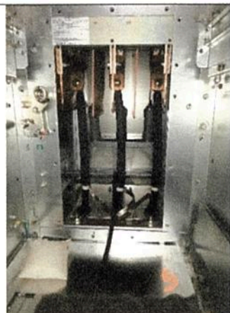
Conexión del alimentador #5 en la celda k08
