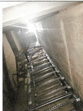
Instalación de bandeja de cables.
