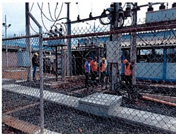
Inspección de material y trayectorias para la reubicación de los alimentadores #1 y alimentador fotovoltaico.
