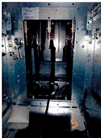
Conexión del alimentador #5 en la celda k08
