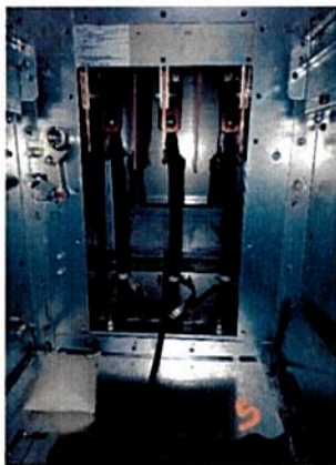
Conexión del alimentador #5 en la celda k08
