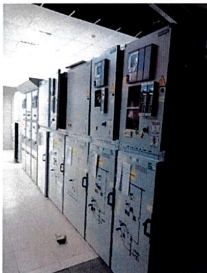
Ensamble mecánico de las celdas NXAIR
