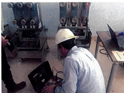
Ensamble mecánico de las celdas NXAIR
