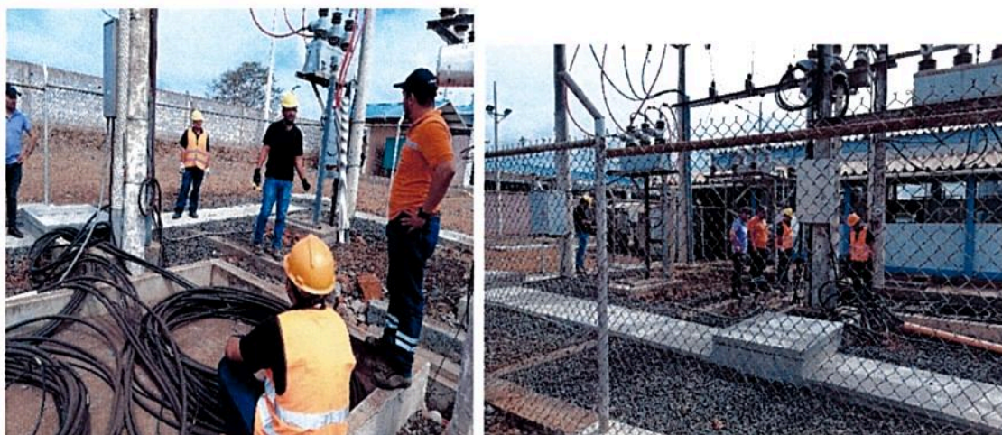
Inspección de material y trayectorias para la reubicación de los alimentadores #1 y alimentador fotovoltaico.
