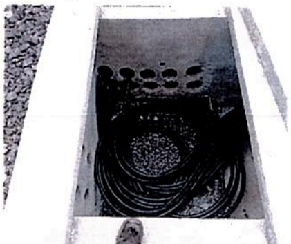
Cable nuevo en trinchera
