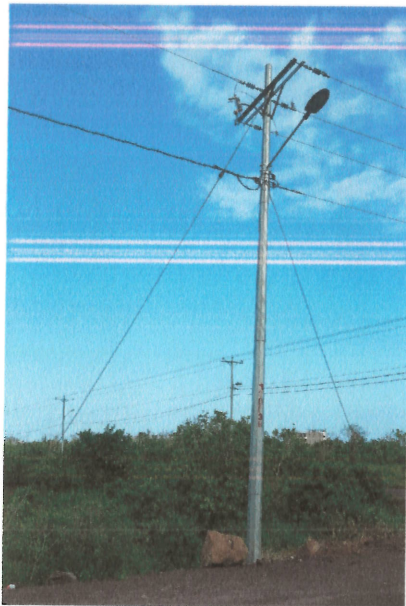
Fig. 3 Instalación de 3CR+1PR3+1CR+OTS13.8+1OTS240+Luminaria
