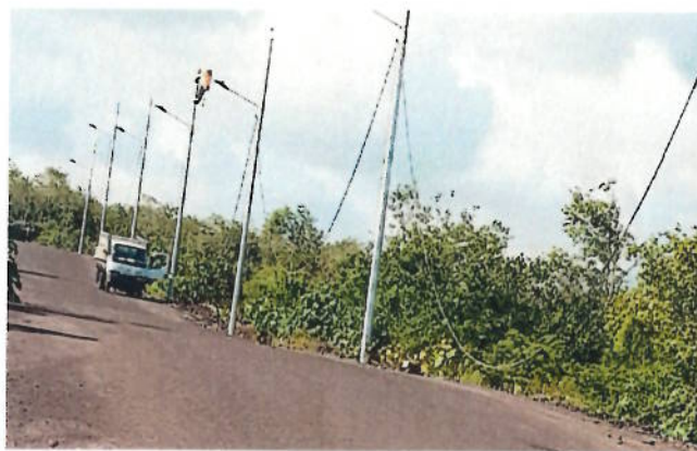
Fig. 5 Tendido de Red M/V y B/V
