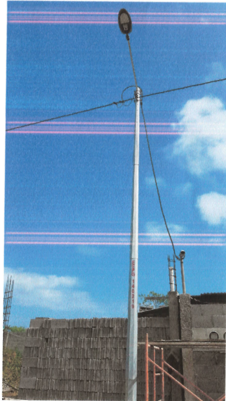
Fig. 5 Instalación de 1PP3+AC (2*4+4)+Luminaria
