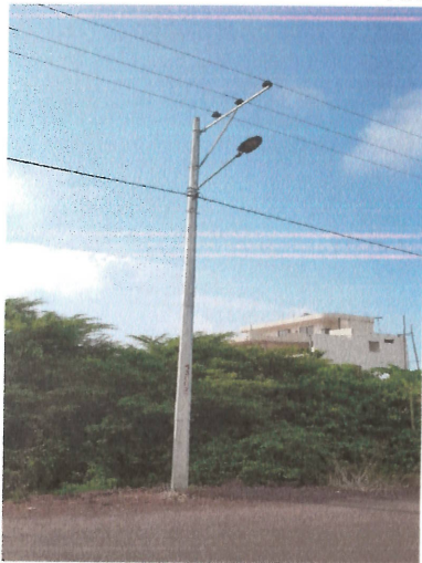
Fig. 1 Instalación de 3VP+1PP3+Luminaria
