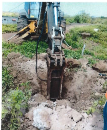
Fig. 2 Perforación para Postes
