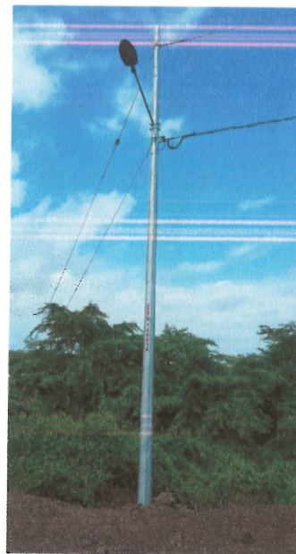
Fig. 4 Instalación de 1CR+1PR3+OTD+Luminaria
