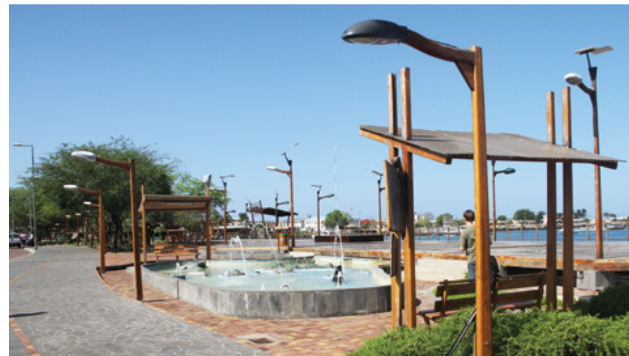
Nuevas luminarias eficientes para el ahorro de energía
